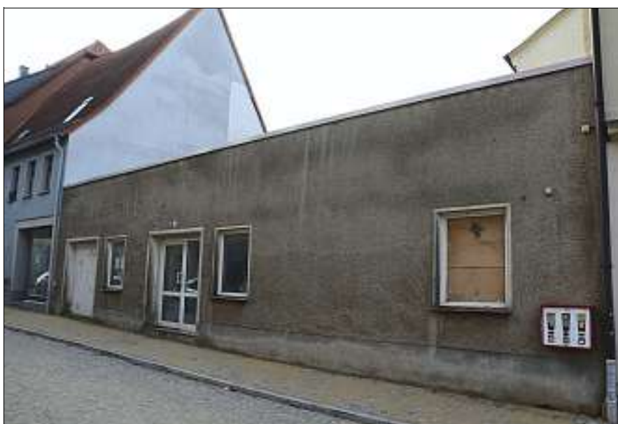
Die Fassade soll auch komplett neu gestaltet werden.
